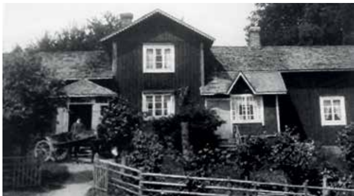
Yli-Eskolan vain kahdeksan vuotta vanha rakennus tuhoutui suurpalossa 1945. Kuvassa samalla paikalla ollut 1930-luvulla purettu talo. Kuvat Anja Lehtiseltä
