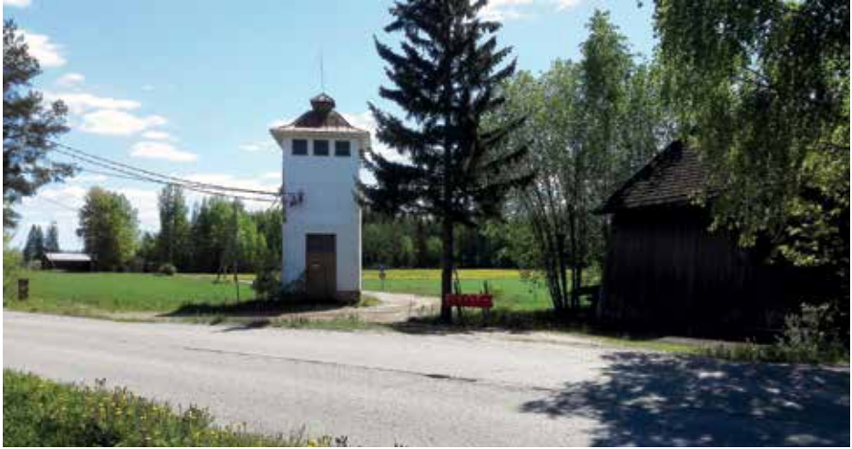
Kulttuurihistoriallisesti arvokas Rusutjärven muuntamo vuodelta 1934. Muuntamon takaa kulkee An-nankorvenkuja, jonka suunnassa oli satoja vuosia kinttupolku Hyrylään. Oikealla Eskolan tanssiladon kulma. Kuva Heikki Simola
