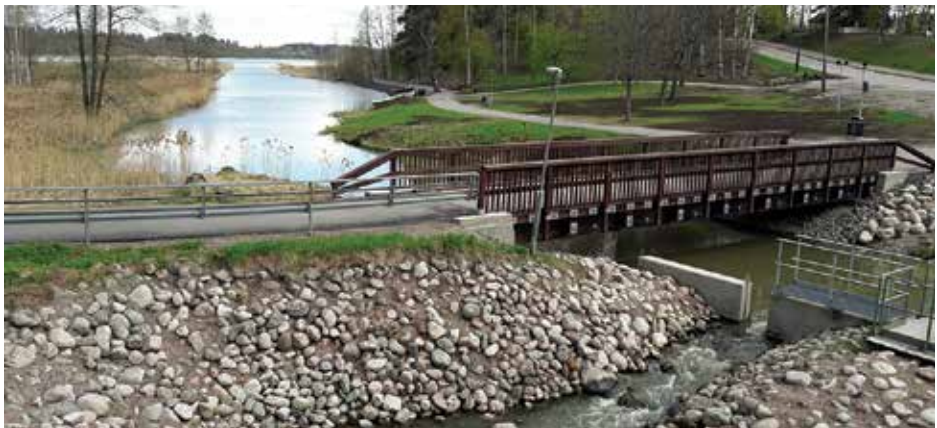
Koskensäillan nykyinen pato on tehty vuonna 1958 ja se liittyy Tuusulanjärven käyttöön Helsingin varavedenlähteenä. Pato on uusittu ja kalaportaat rakennettu hiljan. Taustalla ikaikainen Venavalkama ja Tihunmäki, nyt kunnostettuna osa Valkaman puistoa. Kuva Heikki Simola
